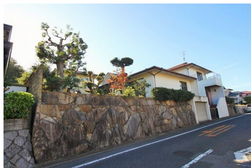
古屋雨漏り有り
